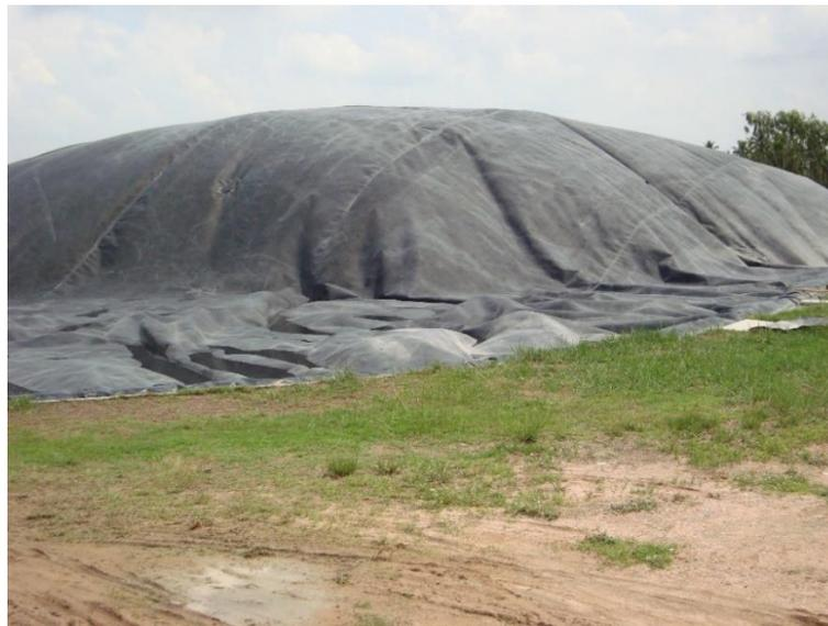
*Photo27. Chambre à air de conservation des gaz produits à partir des effluents liquides de manioc Thaïlande.*
